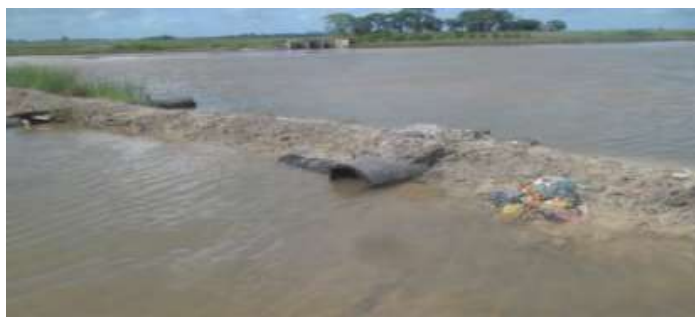
Fig,12 : Système de drainage traditionnel
